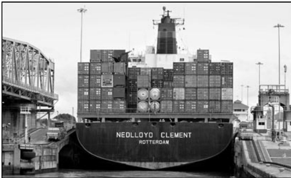
Le navire PanaMax Nedlloyd Clements s'enfile dans les écluses de Miraflores à Panama City.
