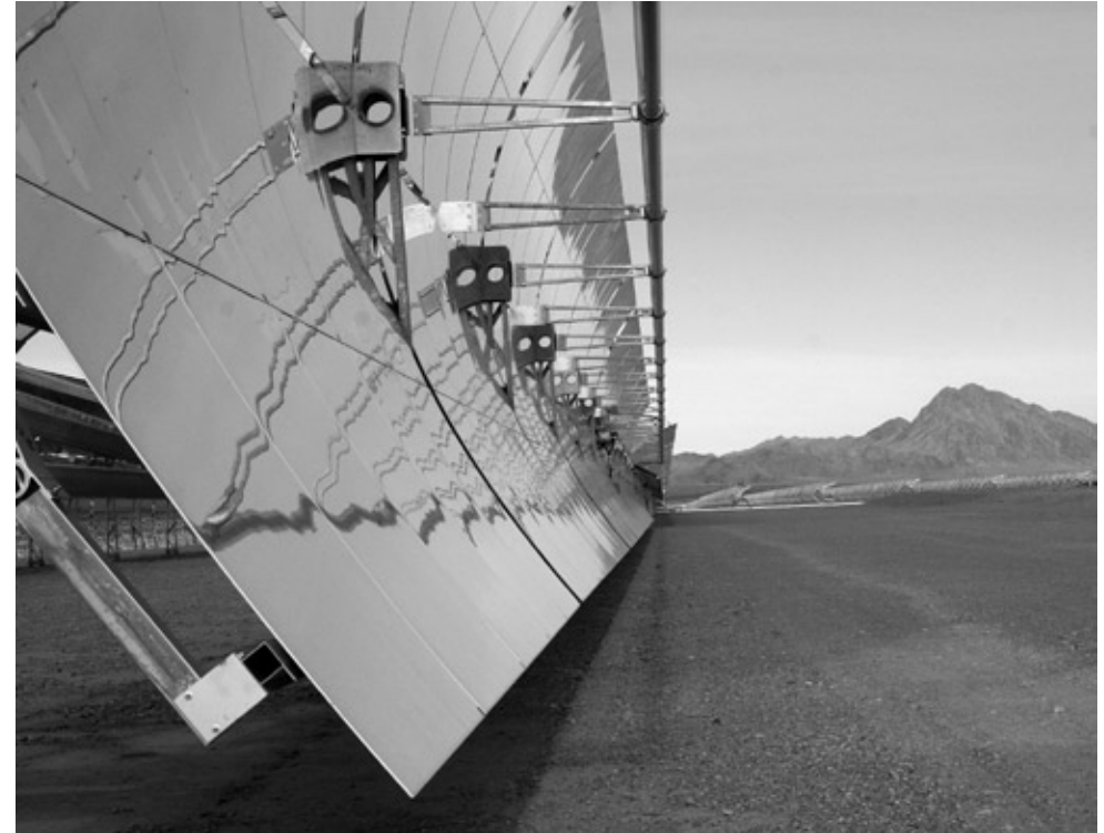
Un système de miroirs cylindro-paraboliques et son capteur faisant partie de Nevada Solar One
