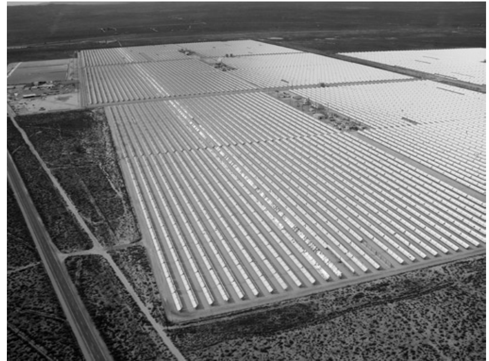
Vue aérienne d'une partie du projet Solar Electric Generating Systems à Kramer Junction, en Californie.
