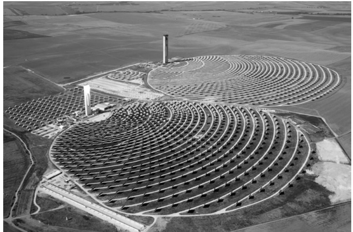
Solucar PS10, une centrale par concentration des rayons solaires à proximité de Séville, en Espagne. PS20 est en construction en arrière-plan.
